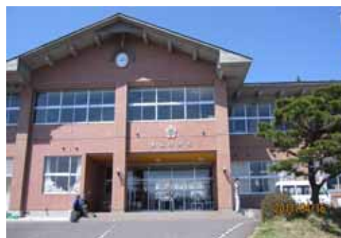
図2 避難所利用されている旧小学校
